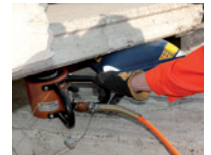
So wird Raum für den Einsatz eines Hebezylinders geschaffen
