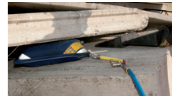
Das Hebekissen wird aufgeblasen und zusätzlich durch Stabilisierungsblöcke gesichert
